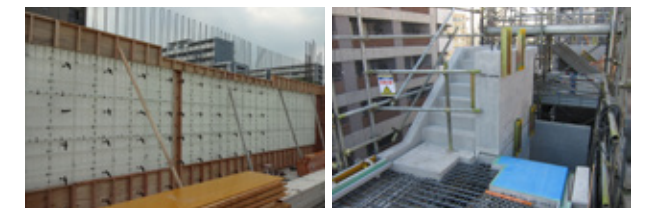
樹脂型枠の使用状況（一部木製型枠） PCa 部材使用状況（フル PCa 階段）
