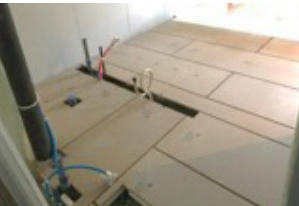
作業所の二重床材として使用
