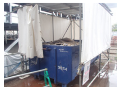
廃石膏ボード分別ヤード（屋根とシートによる防雨対策）
