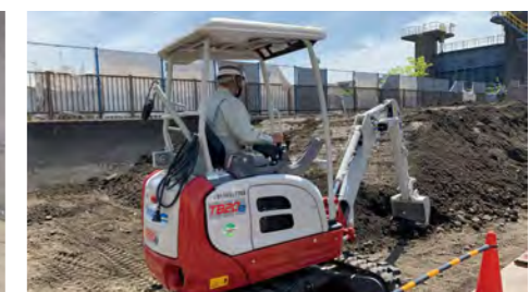
電動バックホーの採用 (試験採用)
