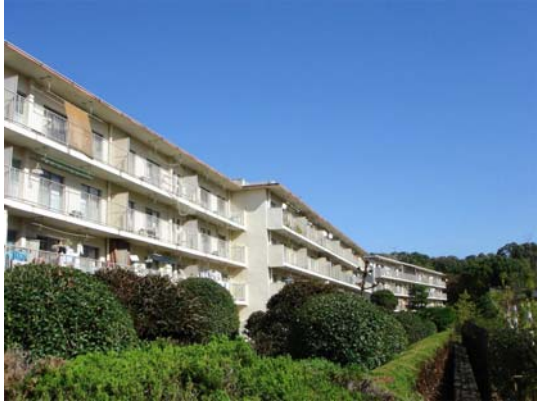
「東丘住宅」現況建物（敷地南側から）
