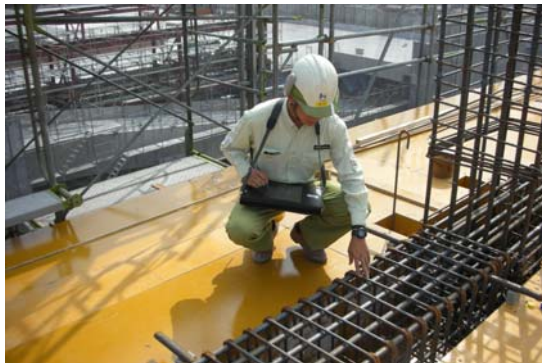
[タブレットPCを使用して配筋検査している様子]
