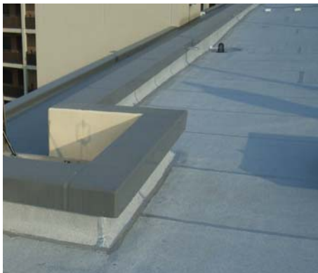
【従前の庇形状をしたパラペット】
