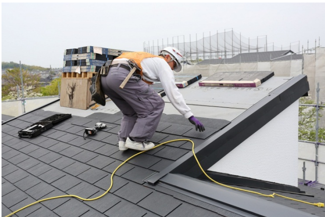
[屋根の工事風景]
