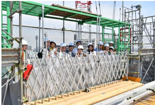
[工事用エレベーターの試乗体験]
