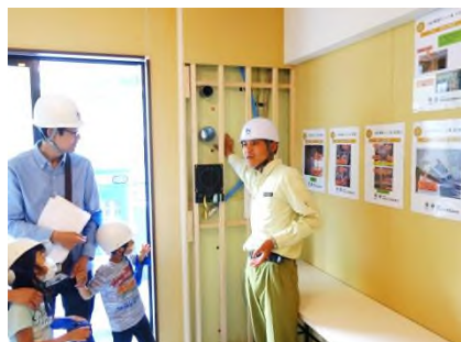
[現場施工見学]
