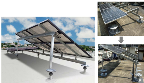
【「リフォーム用ソーラーパネル架台」(左)、パネルを持ち上げて作業スペースを確保(右)】
