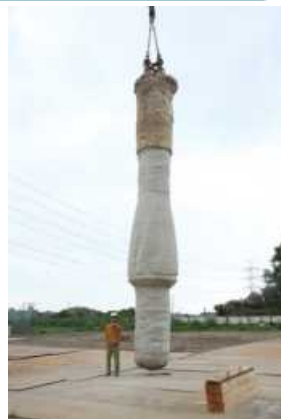
【HND-NB工法により施工した杭】
