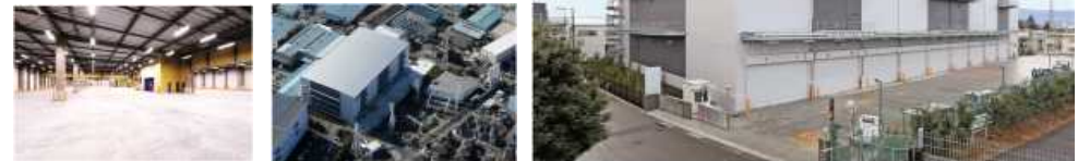
【左：「MCUD座間」倉庫内部、中央：空撮、右：外観】
