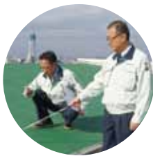
● 屋上防水調査
