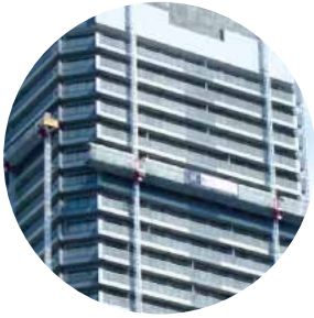
「移動昇降式足場」
