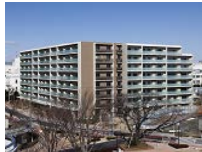
「オーベルグランディオ吉祥寺Ⅰ」 都市再生機構との事業協力による 仮住まい不要の建て替え
