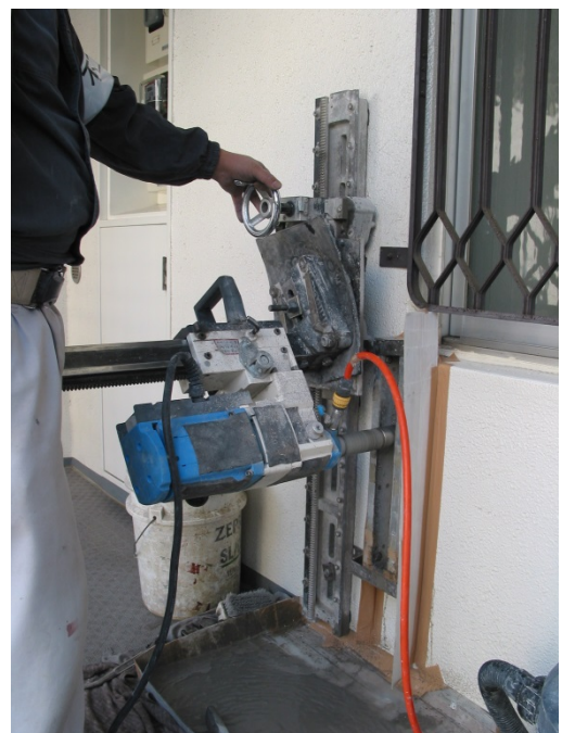
[後施工部分スリットの施工風景]
