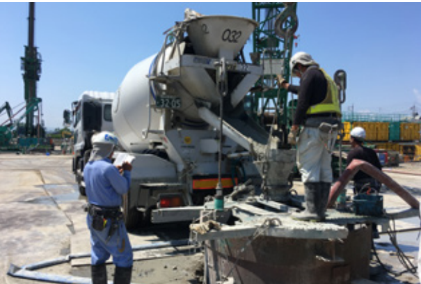
杭コンクリート打設
