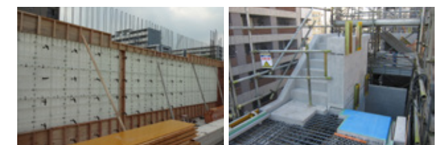
樹脂型枠の使用状況（一部木製型枠） PCa 部材使用状況（フル PCa 階段）
