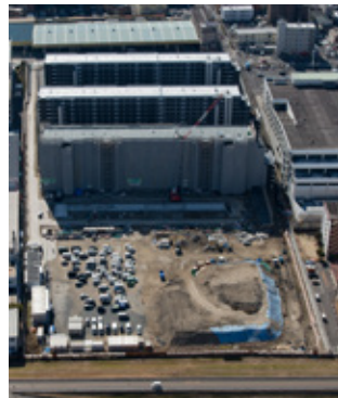
埋戻しが完了し残土（場内堆積分）を搬出する前の状況
