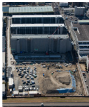
埋戻しが完了し残土(場内堆積分)を搬出する前の状況
