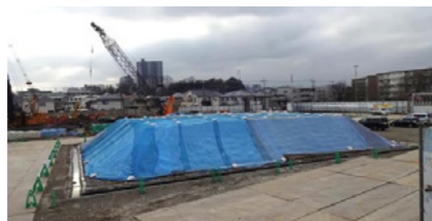
飛散防止対策の状況
