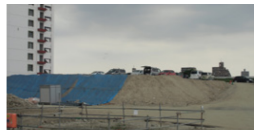
掘削残土の場内堆積状況
