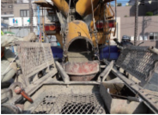
杭コンクリート打設
