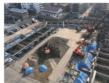
場内仮置き土砂の基礎躯体周りの埋戻し転用状況
