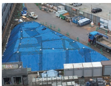
飛散防止対策の状況
