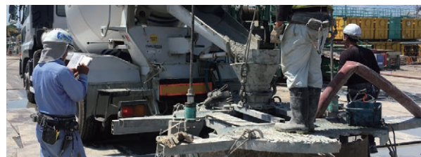
杭コンクリート打設
