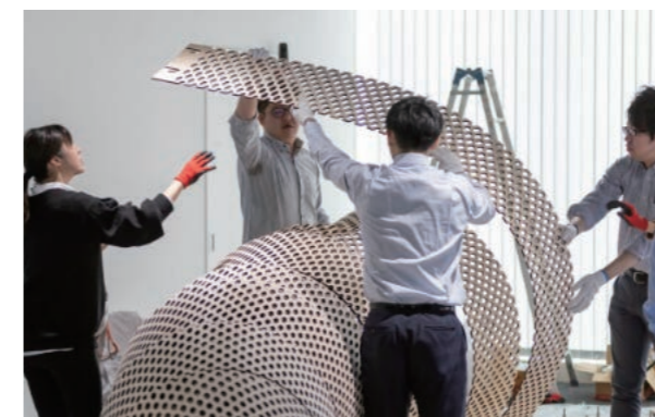
ベニヤ板にあける穴の密度を変化させ、視線透過度・曲げやすさ・弾性を制御する「ウロコシステム」を活用し、ベニヤ板をスパイラル状に連続させてパビリオンを構成
