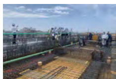
H-BAコンクリート打設の様子
