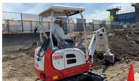
電動バックホーの採用(試験採用)
