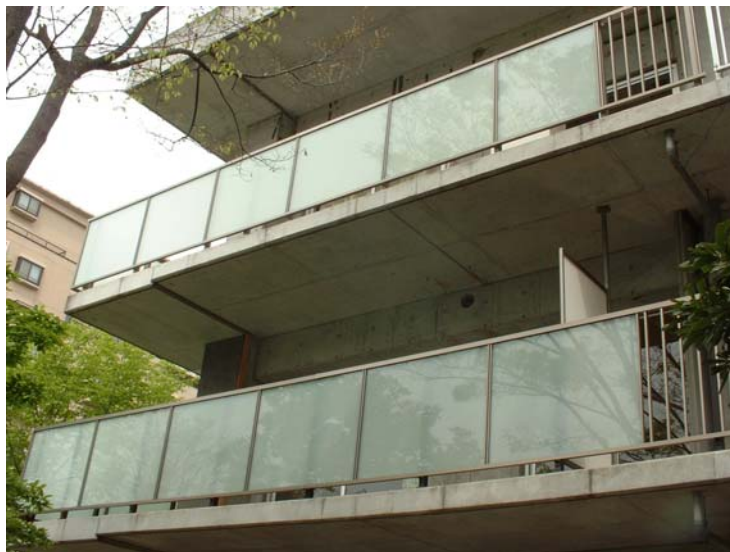
〔「ユニット型手摺」の施工例〕
