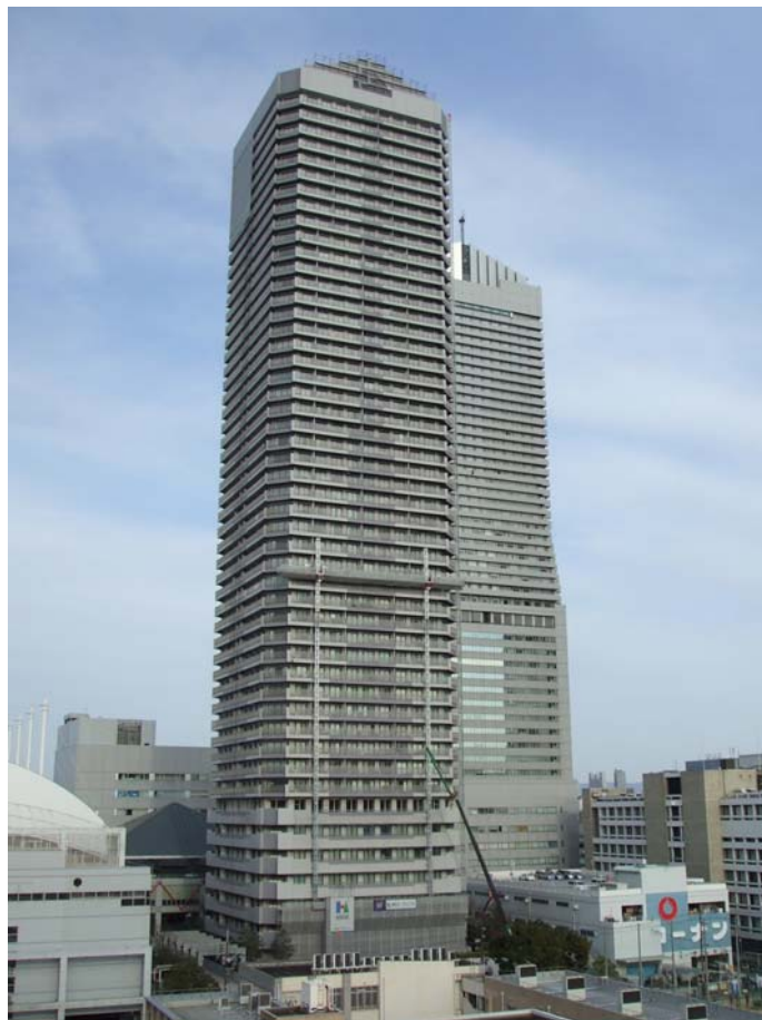
〔「オークプリオタワー」大規模修繕工事風景〕
