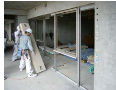
④ALCパネル取付
