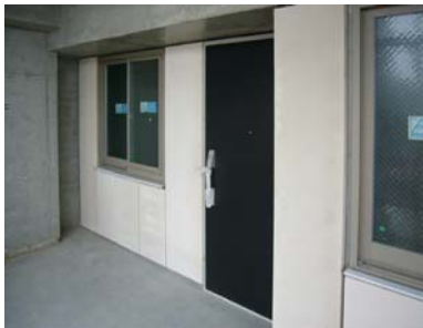
⑥完成（開放廊下側 外観）
