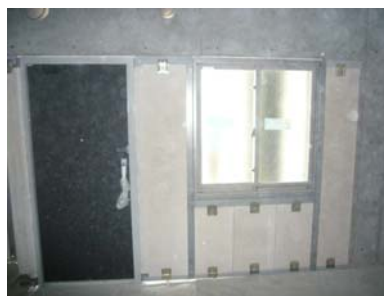
⑥完成（開放廊下側 内観）
