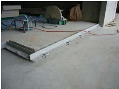
②サッシユニット固定用 レール取付（写真は下部）
