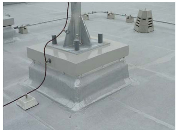
【『S型枠』を用いた施工例】
