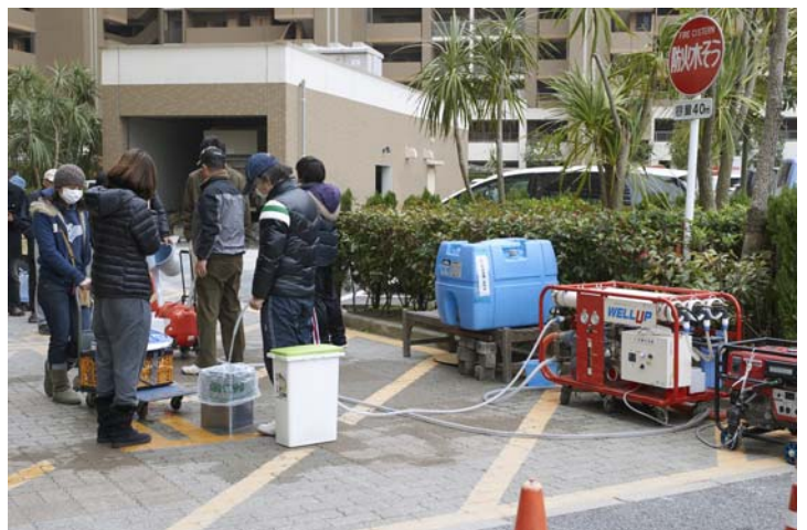
【東日本大震災での稼働風景】
