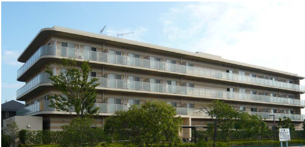
【『ライブガーデン千葉浜野』建物外観】
