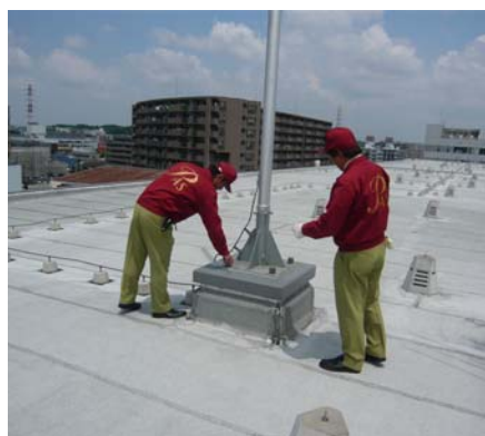
〔定期点検の様子〕
