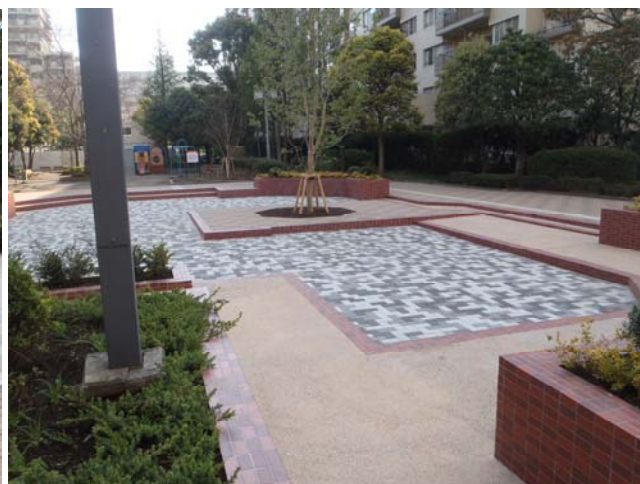
〔改修工事後のじゃぶじゃぶ池〕
