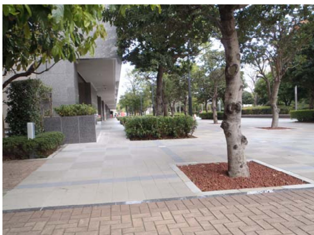
〔復旧工事後の敷地内通路〕
