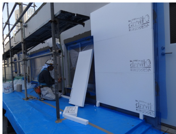
【多摩ニュータウンの再生技術（外断熱改修）】
