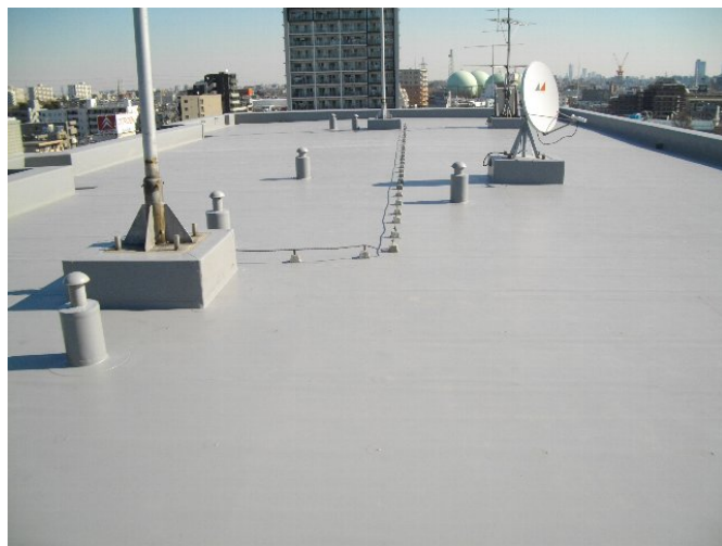
〔左：改修前（アスファルト防水）、右：改修後（シート防水）〕
