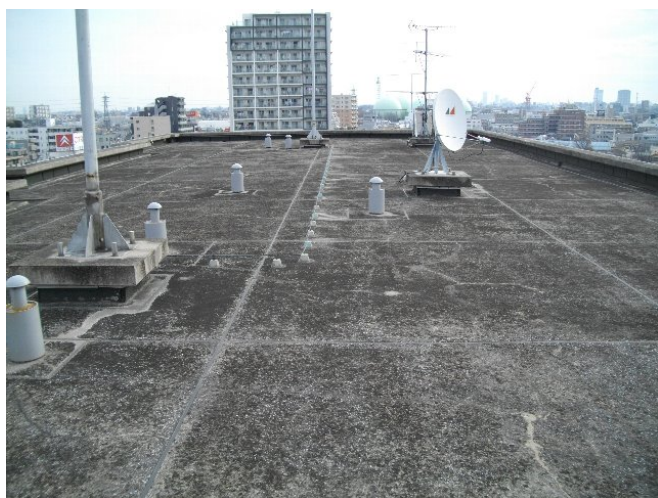
〔左：改修前（アスファルト防水）、右：改修後（シート防水）〕
