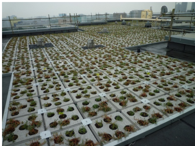
【「屋上緑化保水板」の設置状況】
