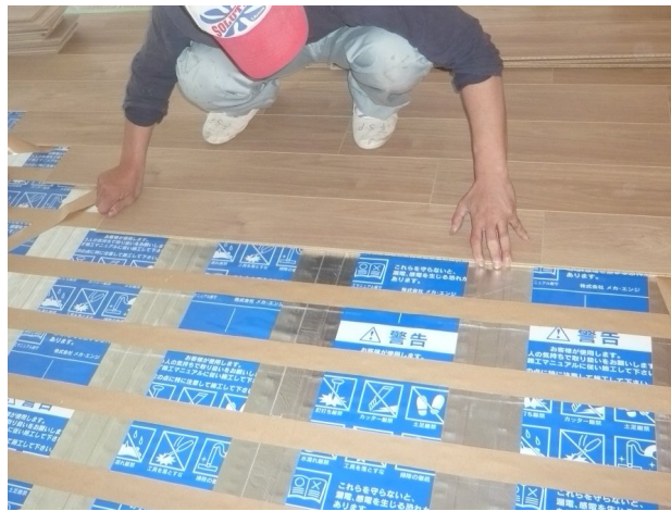
【『暖cer-R』を施工している様子】
