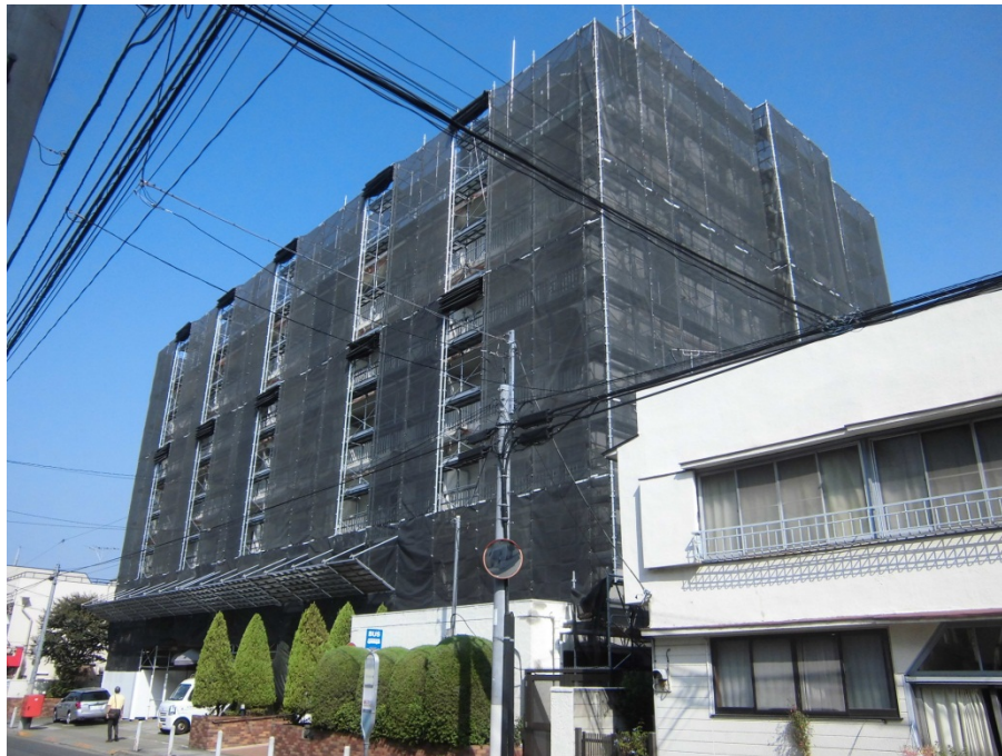
[ 「楽巻君」を試験採用した大規模修繕工事物件の外観 ]
