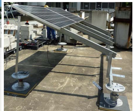
〔「リフォーム用ソーラーパネル架台」（左）、パネルを持ち上げて作業スペースを確保（右）〕
