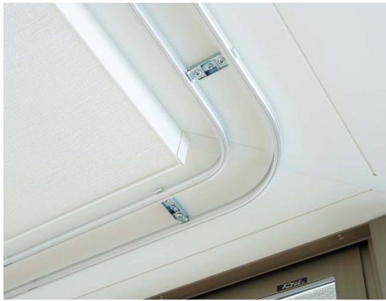
[左：従来のカーテンレール（アルミ製・曲線部）、右：カーテンレール内蔵の樹脂製カーテンBOX（コーナー型）]
