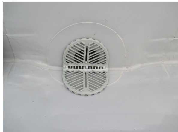
〔左：排水部の防水改修前、右：ルーフドレン更生工法（横型）による防水改修後〕
