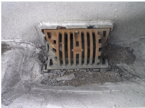
〔左：排水部の防水改修前、右：ルーフドレン更生工法（横型）による防水改修後〕
