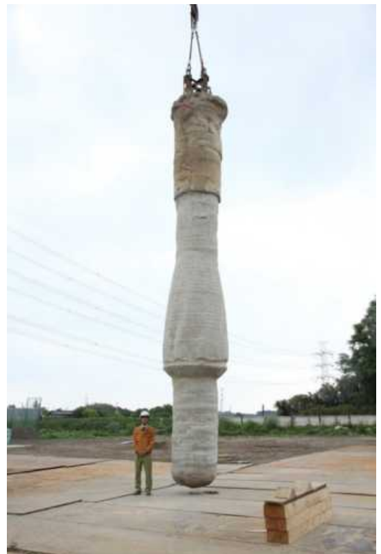
【HND-NB工法で施工した杭（中間拡径部）】
