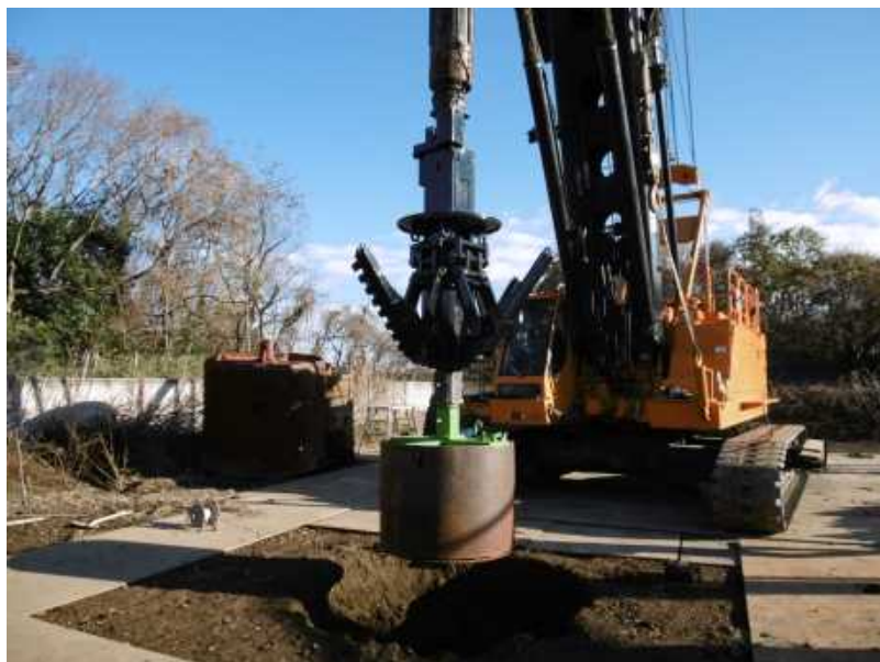
【HND-NB工法による施工風景】
