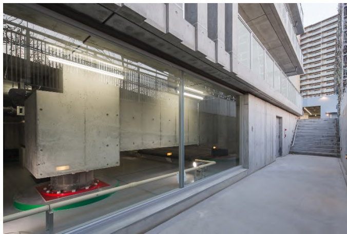
〔住宅実験棟（免震層）〕
