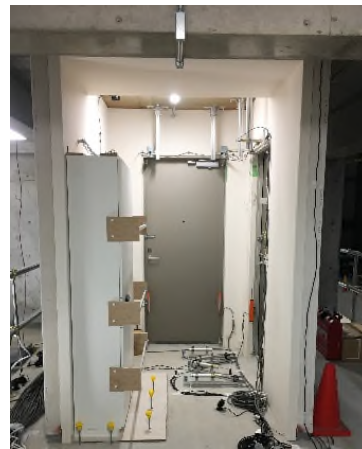
[内外装実験室 (収納建具、内装仕上げ状況)]
