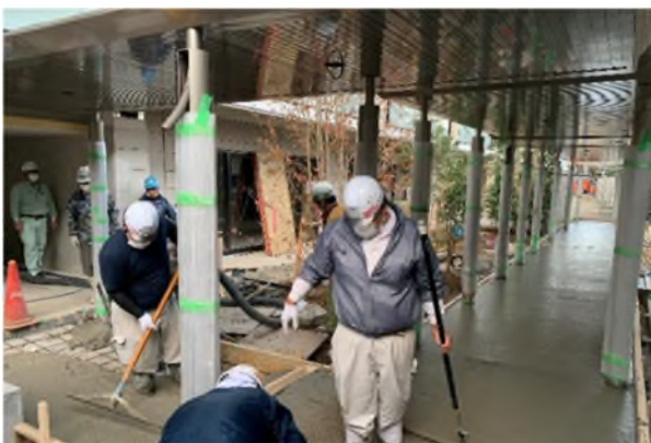
[H-BAコンクリートが採用された中庭の回廊]
