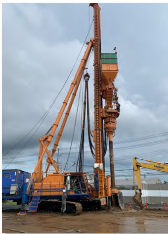
施工実験状況
