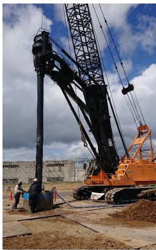
アースドリル機施工実験状況
