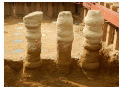
締固め固化砂杭 掘出し (自立確認)
