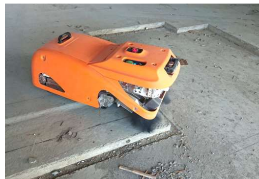
現場で清掃をしている様子
