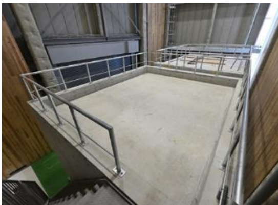
A室 天井スラブ
