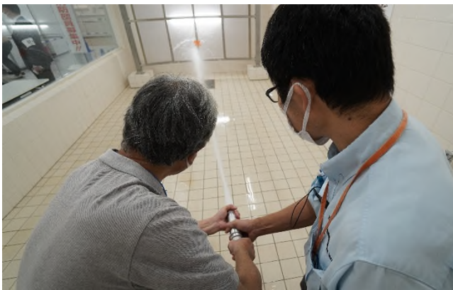
屋内消火栓を使用した放水体験
