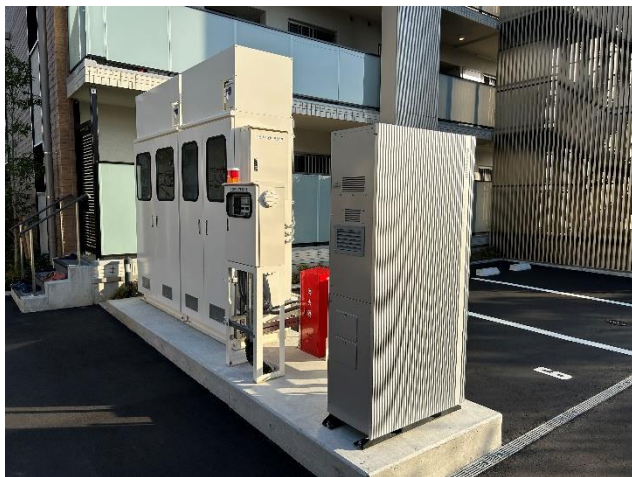
現地設置風景
