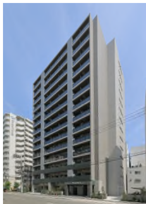
【外観ファサード】
