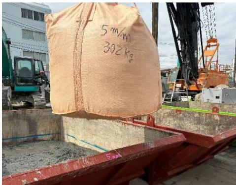
建設汚泥への竹チップ添加
