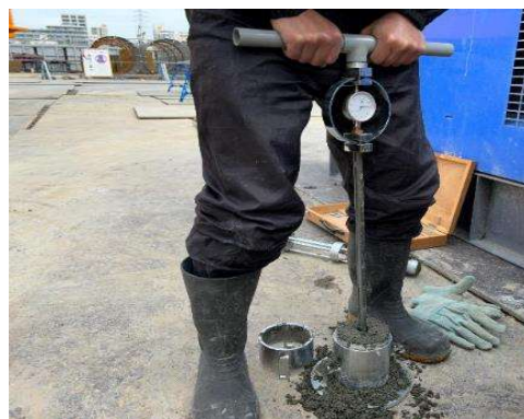
品質検査（コーン貫入試験）
