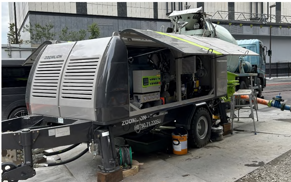
【電動定置式コンクリートポンプによる稼働の様子】
